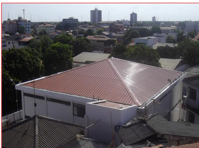
Vista do bloco novo, onde está localizado a cozinha, refeitório, SND, e residência médica
